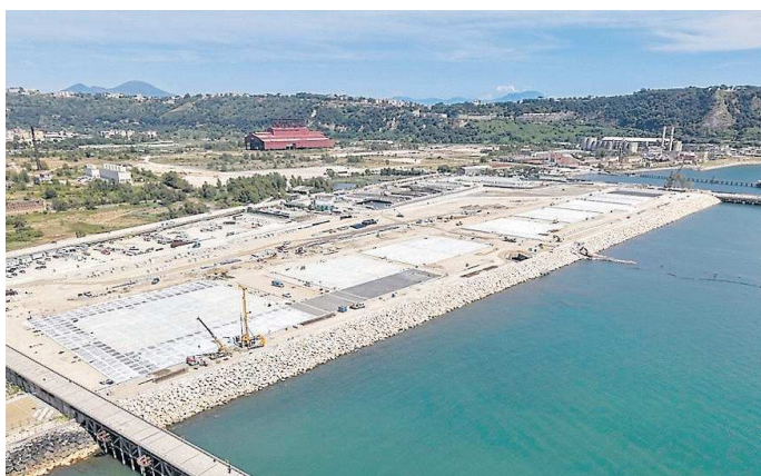
GLI HANGAR Da sinistra New Zealand, GbI, base AC40, Luna Rossa, Alinghi, La Roche, Usa e Australia
